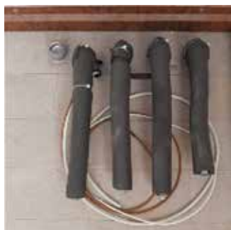
Esempio installazione con tubazioni dal pavimento
