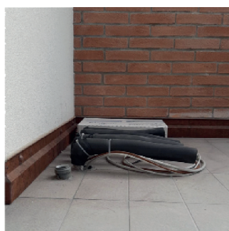
Esempio installazione con tubazioni dal pavimento
