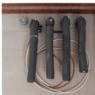
Esempio installazione con tubazioni dal pavimento
